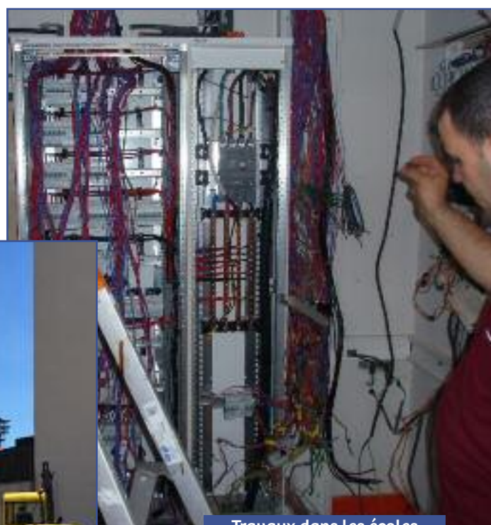
Travaux dans les écoles
